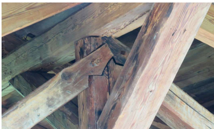
36 impasse du Véroce, cet assemblage en bois se retrouve sur les pannes des fermes et a été aperçu au Temple de Chêne, à Genève.
