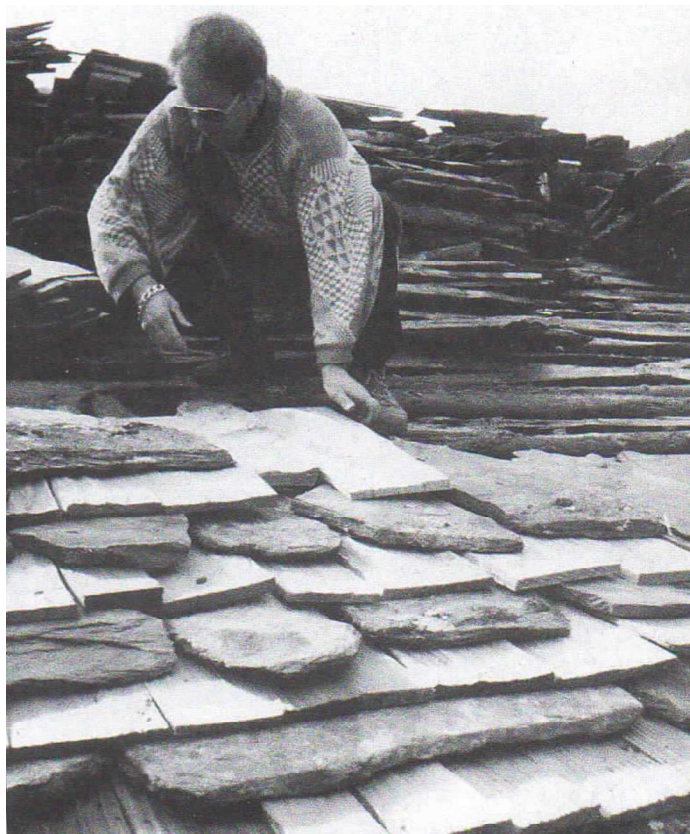
Photographie issue de Saint Gervais et le Val Montjoie, Mémoire en Images, Gabriel Grandjacques, éditions Alan Sutton. Au Crozat, chez les Bochatay, la toiture traditionnelle faite d'ancelles et de pierres plates
