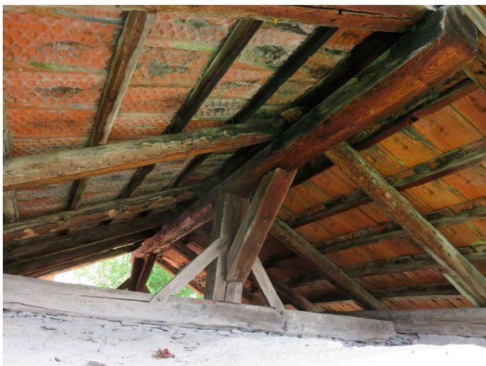
Les plans d'en bas, vue générale sur la charpente, deux fermes, chevrons, liteaux et tuiles mécaniques
