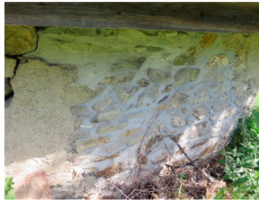
Vue 4. 401 Route de l'Emey. Reprises de maçonneries au ciment
