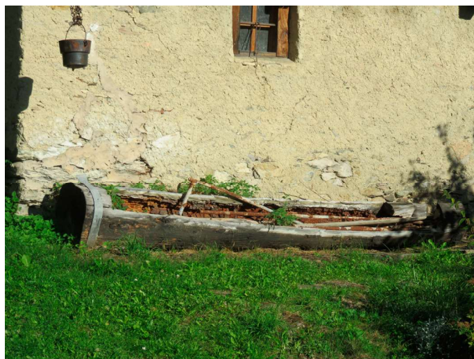
Le Quart, bassin à l'abandon
