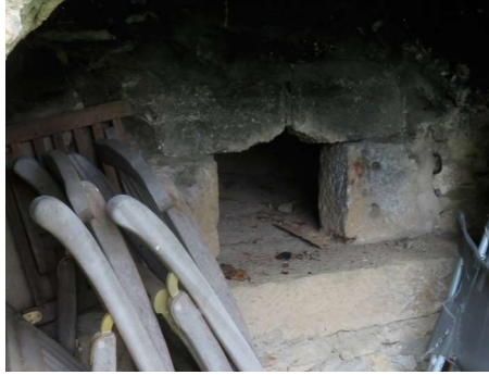
366 chemin de l'Erney, bouche en bloc de pierres de taille
