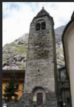
Le campanile de Valgrisenche avant sa restauration
